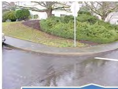
ADA Ramp Program
